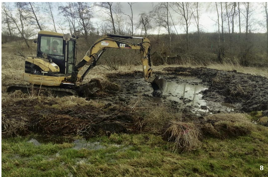
8 Budování nové tůně u Opatova. Terénní práce by měly probíhat mimo vegetační sezonu. Snímky F. Kounka, pokud není uvedeno jinak
