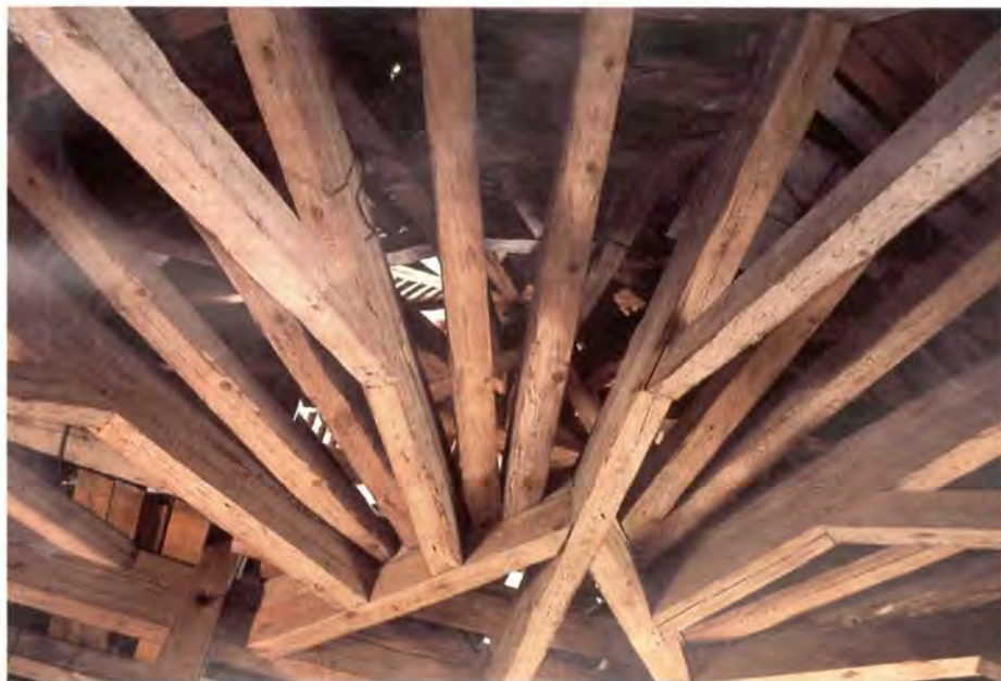
Odběr vzorku dřeva pomocí Presslerova vrtáku. V otevřeném vrtáku je vidět vývrt (nahore vpravo) ♦ Barokní část krovu kopule zámku ve Vranově nad Dyjí je výlučně z jedlového dřeva. Několik krokví vyměněných při opravě v 19. stol. je vesměs borových. Snímky J. Kyncla
